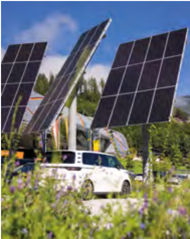
Auf dem Parkplatz der Schlossalmbahn lässt sich Strom tanken, der vor Ort produziert wird.
